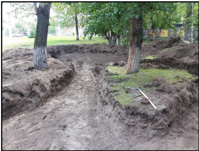
Строительство пруда для лаборатории по «Подводной робототехнике».
